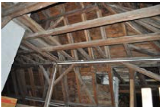
Obr. Stav krovů a věžičky před a v průběhu opravy
