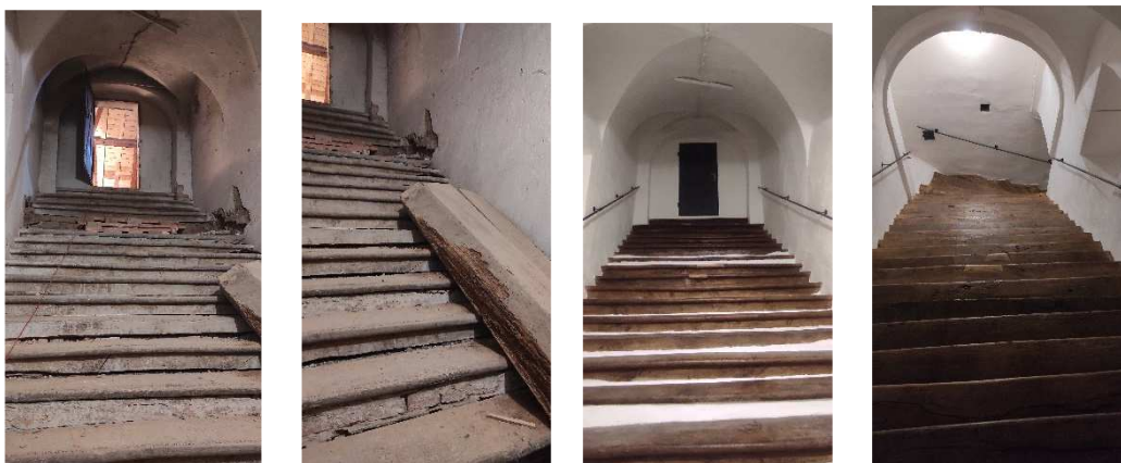
Obr. – fotografie opravy vstupního schodiště včetně schodišťových stupňů (před a po realizaci)
