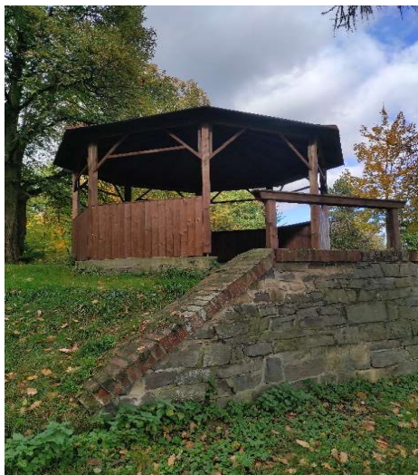
zahradní altán po výměně dřevěné konstrukce
